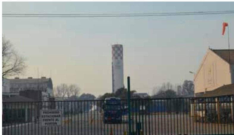
La planta industrial de Atanor en San Nicolás de los Arroyos.
